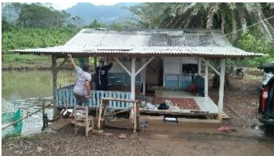
Gambar 5. Pemasangan Panel PLTS di Atap Mushola Apung
