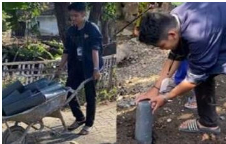
Gambar 6. Pendistribusian dan Pemasangan Biopori
