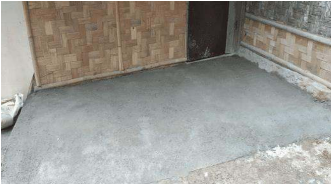
Gambar 8. Perbaikan Lantai Tanah (Sebelum dan Setelah Pendampingan)
