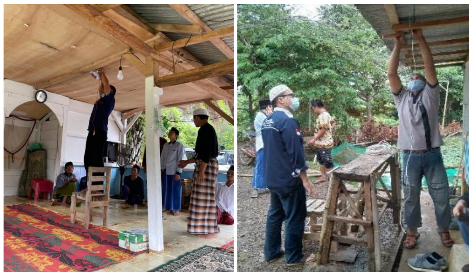
Gambar 6. Pemasangan Instalasi Listrik dibantu Santri dan Pengurus Pesantren
